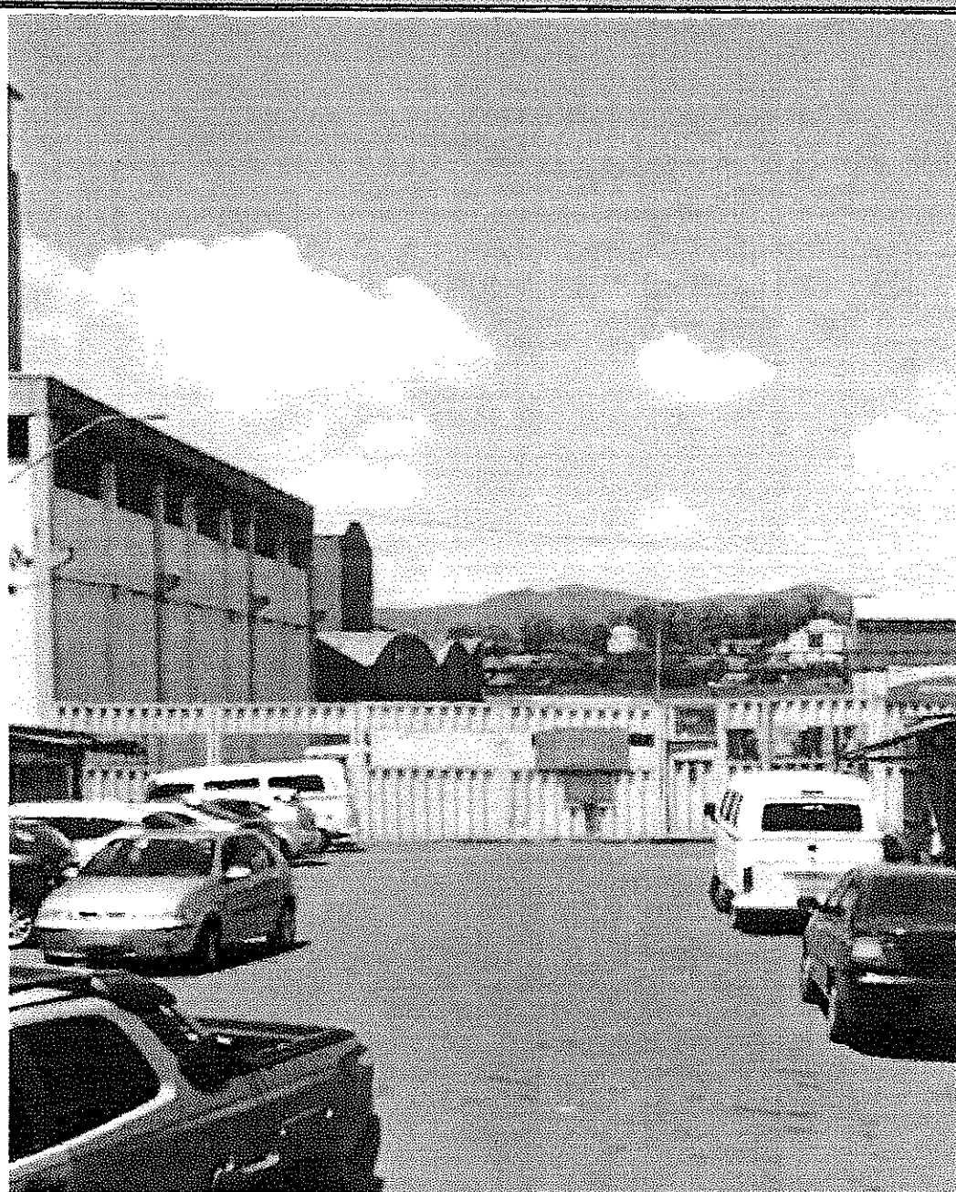
Foto 02 - IMAGEM FRONTAL - Portaria da Empresa para a Rua Pedro Pacheco Fonte: Google Earth - Data Imagem: s/inf.
