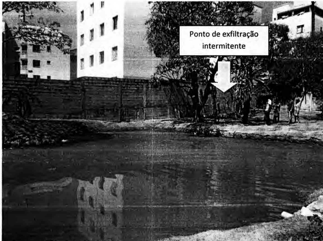
Provável ponto de exfiltração intermitente existente na propriedade. 01/07/2012
