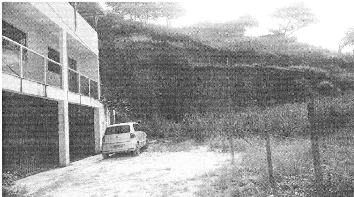
FOTO 02 - 26/*MARÇO /2024 - FINAL DA RUA DAS CASTANHEIRAS - SEM SAIDA
